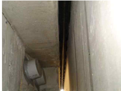
신축이음 유간거리 측정 전경
