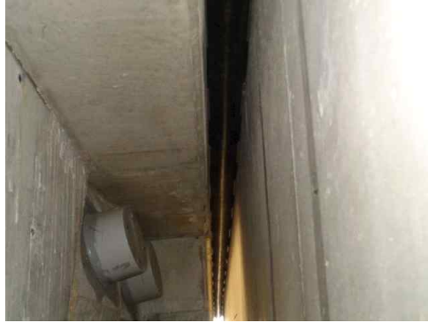
신축이음 유간거리 측정 전경
