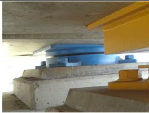
받침장치 상태 양호
