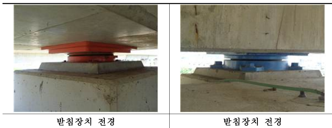
<그림 2.5.16> 교량받침 전경
