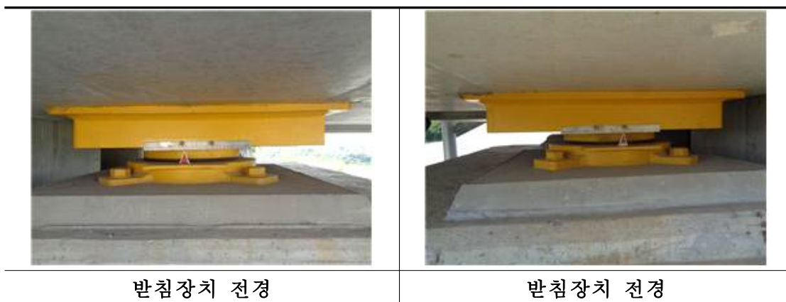
<그림 2.9.13> 교량받침 전경
