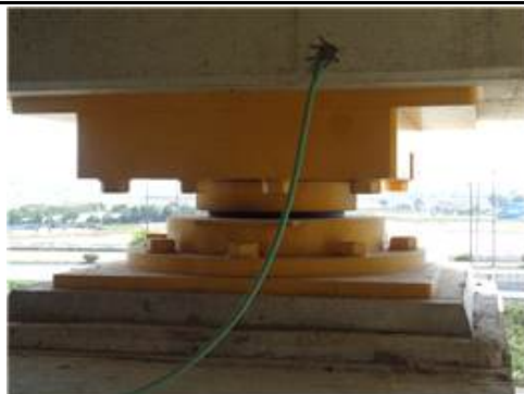
받침장치 상태 양호
