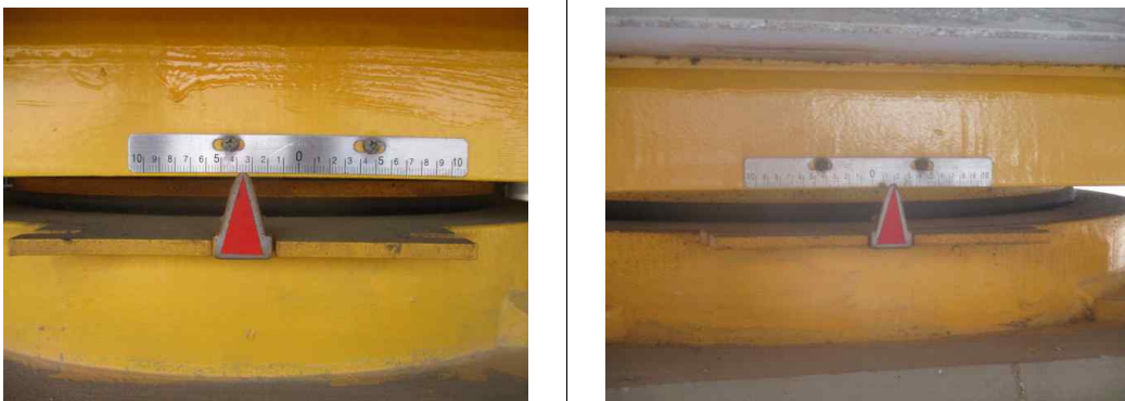
가동량 측정 전경
