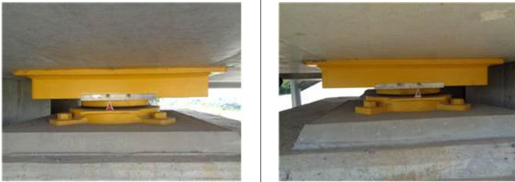
가동량 측정 전경
