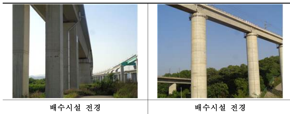
<그림 2.9.7> 배수시설 전경
