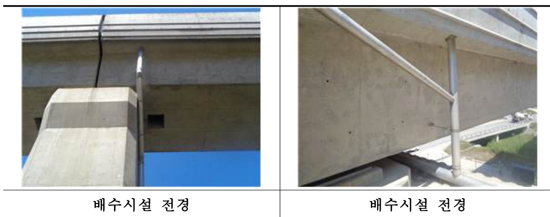
<그림 2.12.7> 배수시설 전경
