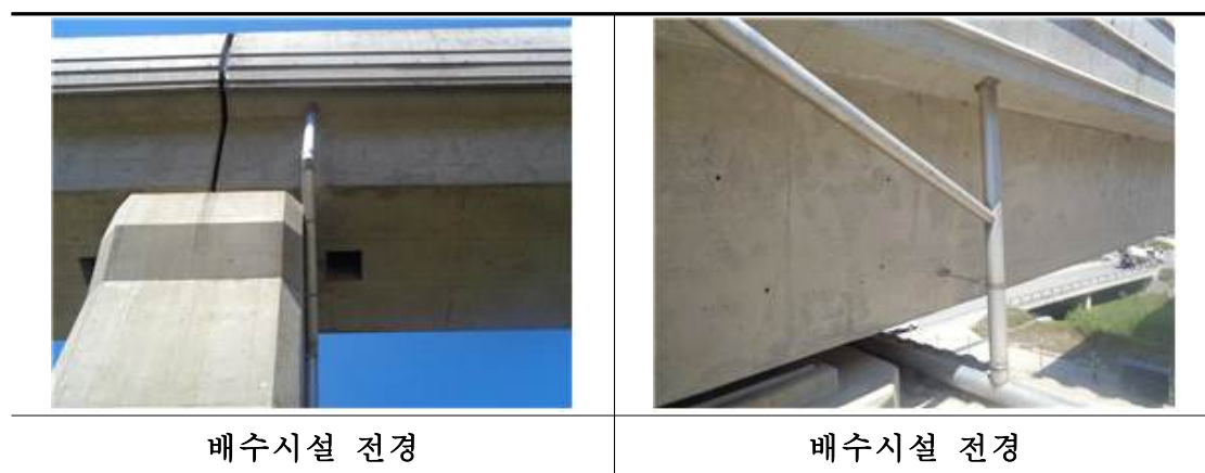
<그림 2.11.7> 배수시설 전경
