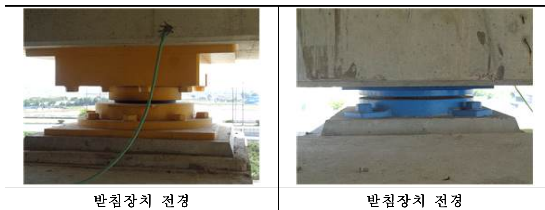
&lt;그림 2.6.16&gt; 교량받침 전경
