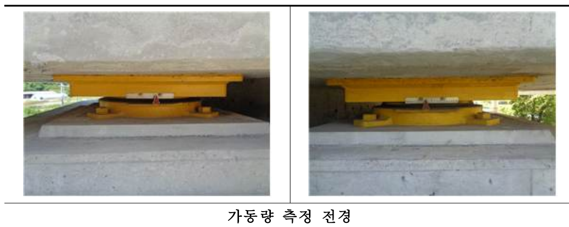
&lt;그림 2.11.16&gt; 교량받침 가동량 측정
