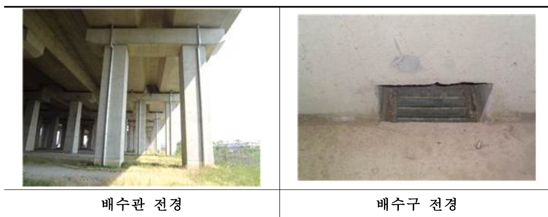
<그림 2.6.7> 배수시설 전경
