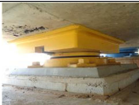
받침장치 상태 양호
