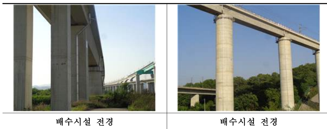
<그림 2.10.7> 배수시설 전경
