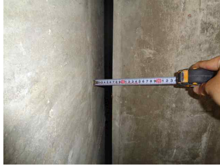
신축이음 유간거리 측정 전경
