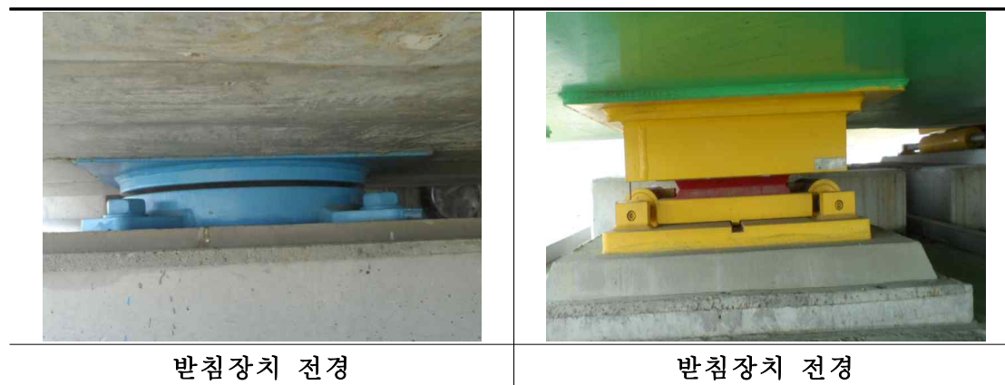
<그림 2.10.13> 교량받침 전경
