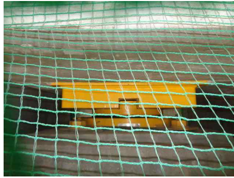
받침장치 상태 양호
