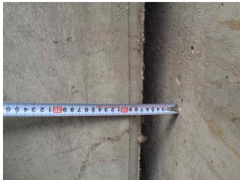
신축이음 유간거리 측정 전경
